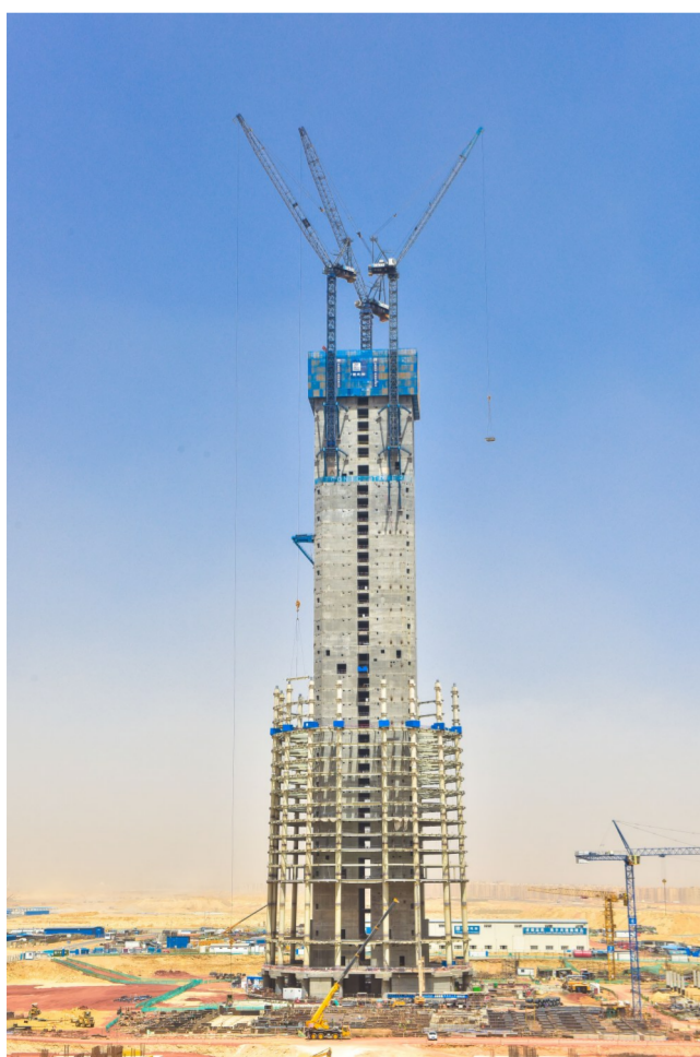
随着钢丝绳起升到位,攀缘在非洲第一高楼——埃及新首都CBD标志塔核心筒外的ZSL380和ZSL850两台动臂塔吊于近日顺利完成高空移位爬升,这也是埃及当地首次实现超高层建筑动臂塔吊高空移位爬升。(林荣茂)
