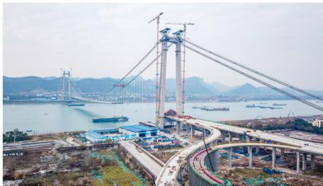
▲农历大年年初,中国建筑首座主跨千米级长江特大桥——宜昌伍家岗长江大桥主塔钢桁架正式整体提升。
