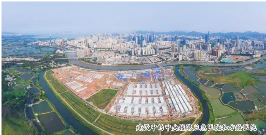
建设中的中央援港应急医院和方舱医院
