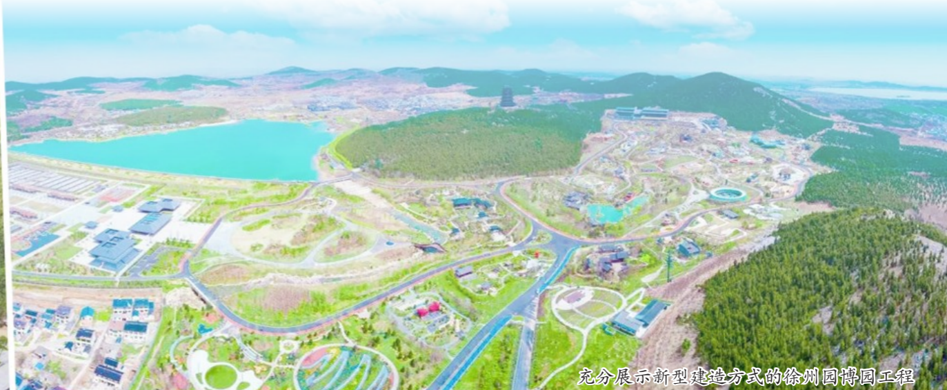
深圳坪山高新区综合服务中心是国内首个EPC装配式钢结构综合体项目
