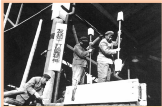
1970年二汽建设期间土洋结合进行“干打垒”施工
