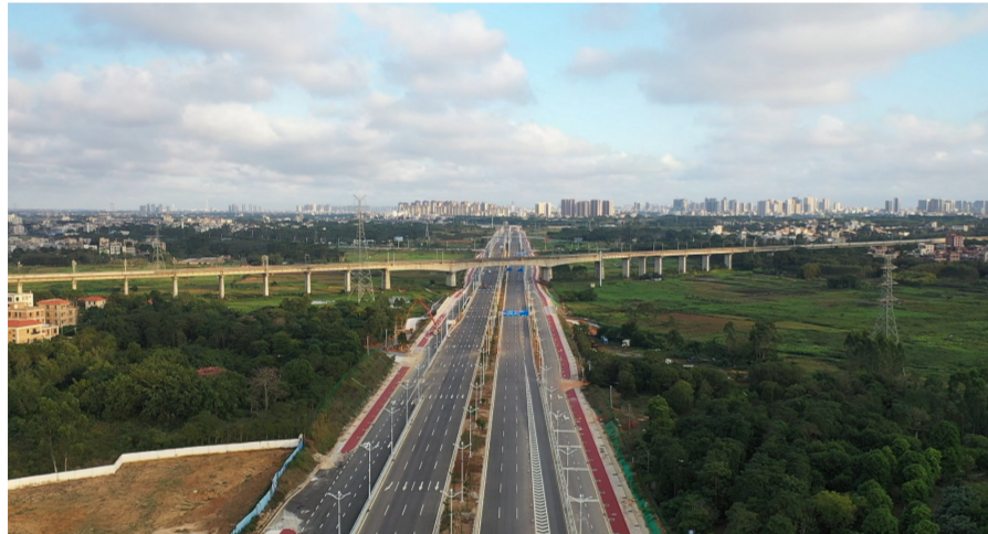
由中建二局华南公司湛江大道项目正式通过竣工验收。项目为一级公路兼城市快速路,主线双向八车道,设计时速80千米,全长21.944千米,是湛江市规划的“双环+十字+十八射”骨架路网系统中的重要组成部分,投用后,将成为湛江市标志性城市主干道,使城市交通有效地与高速公路连接线路等外围道路系统融为一体,为湛江城市发展战略规划起到促进作用。(姚孟龙)
