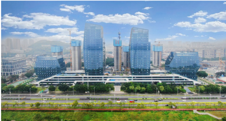
由中建科工承建的金山桥园工业园区项目D正式投入运营。金山桥园工业园区项目D位于福建省福州市,占地面积约2.7万平方米,总建筑面积13.3万平方米,由四栋高层装配式钢结构建筑组成,最高建筑高度为111米。项目以“福船”为原型,紧扣闽都山水大命题,建成后将呈现望山临水的全景山水产业园区,助力福州市实现产城有机融合。(高岚旭)
