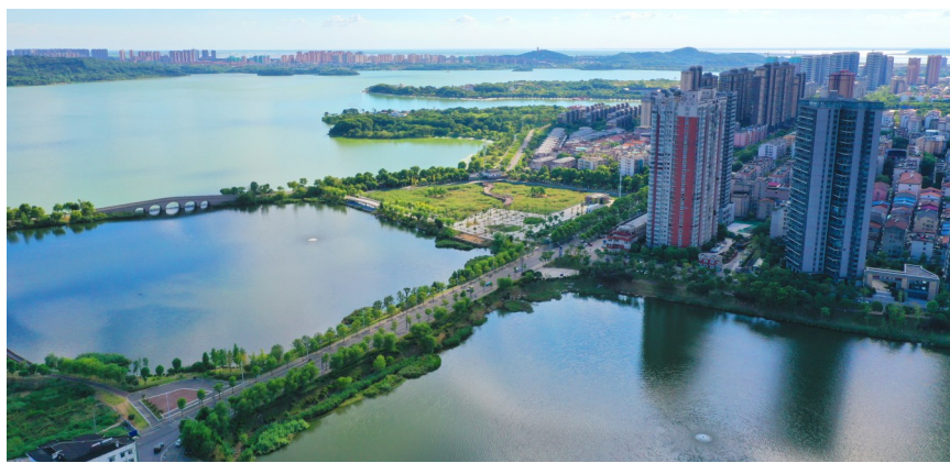
由中建二局西南公司承建的长江大保护岳阳项目南湖游路雨污分流改造工程全面完工。项目的全面完工不仅解决了合流制溢流污染问题,还提升了南湖水质,推动城市基础设施建设,促进岳阳市可持续发展。(唐雪庆)
