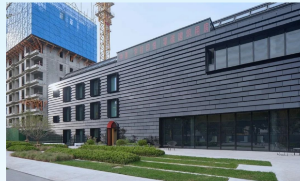
中建一局中建智地充分挖掘“零碳”建筑建设过程中的创效点和降本点。图为中建·学府印悦“零碳”建筑用房,通过建筑光伏一体化、光储直柔、被动技术等为建筑节能降碳。
